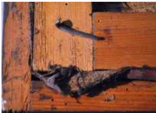
Abb. 197 Historische Reparatur des gebrochenen Spannrahmens
