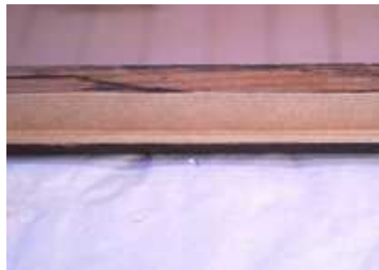
Abb. 212 Mit Börtelstreifen beklebter Rahmenfalz
