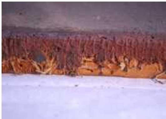
Abb. 94 Verklebung degraderter Kanten mit einer Kittmasse
