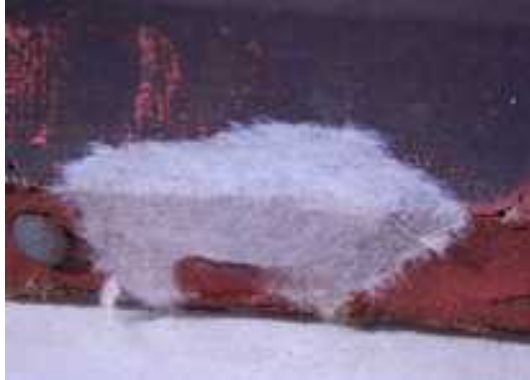
Abb. 194 Japanpapiersicherung
