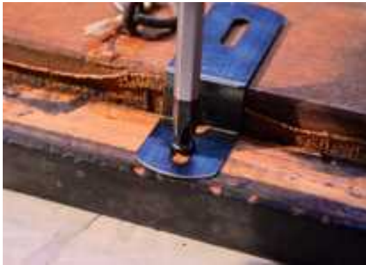
Abb. 213 Anbringen von Federblechen
