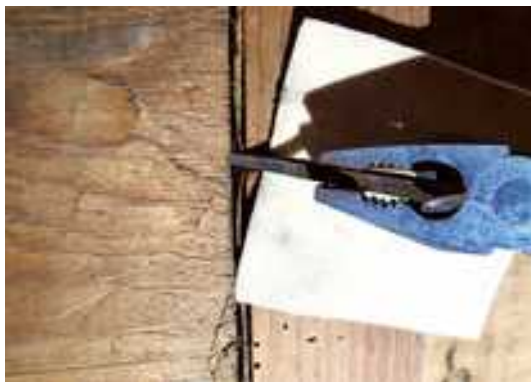
Abb. 207 Ausrahmen: Entfernung der Nägel
