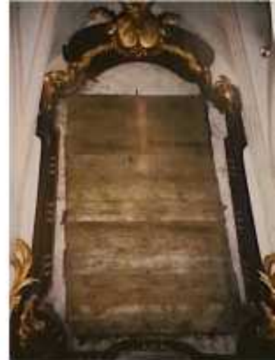
Abb. 171 Brettkasten mit Holzkohlefüllung als Klimaschutz
