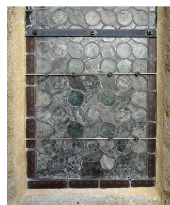
Abb. 186: Bleifeld 1b nach der Aushärtung des Mörtels
