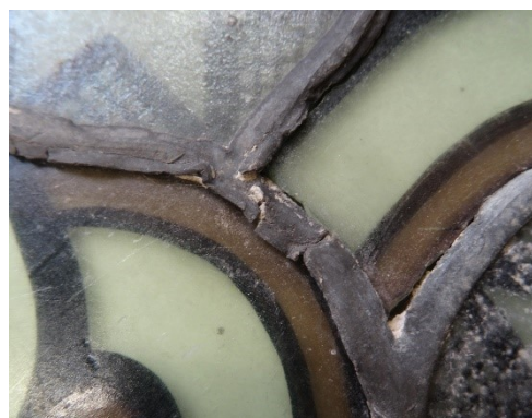
Abb. 138: Eingerissene Bleiruten und Deformierungen
