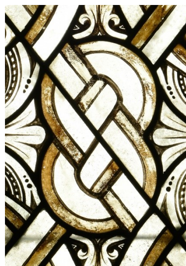
Abb. 122: Verluste der braune Emailfarbe, Innenseite, Durchlicht
