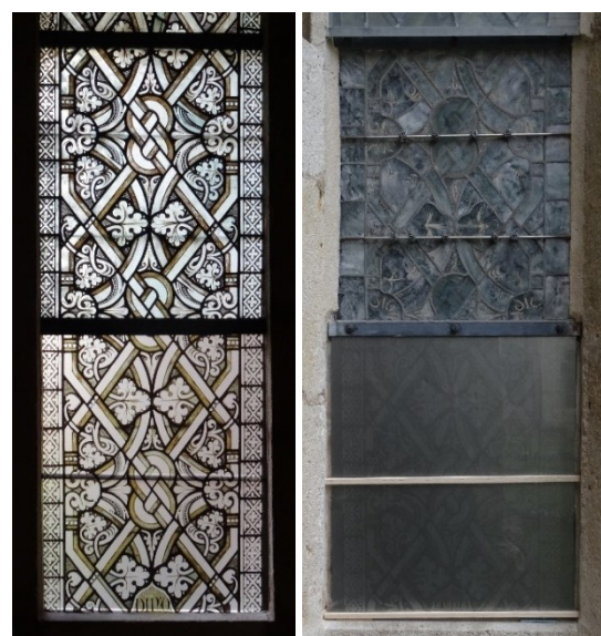
Abb. 154: Floatglasscheibe mit bedruckter Klebefolie im unteren Feld und Holzleisten an der Außenseite (rechte Abbildung)
