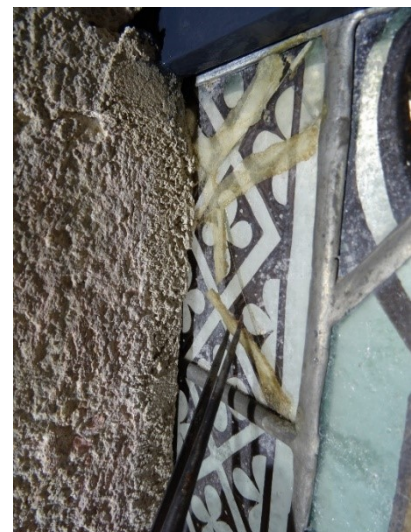
Abb. 156: Entfernen des Klebemittels mit Pinzette
