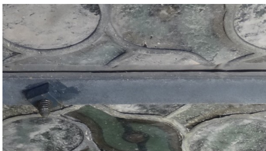
Abb. 113: Durchschnittenene Silikonfuge, Bleifeld 1b
