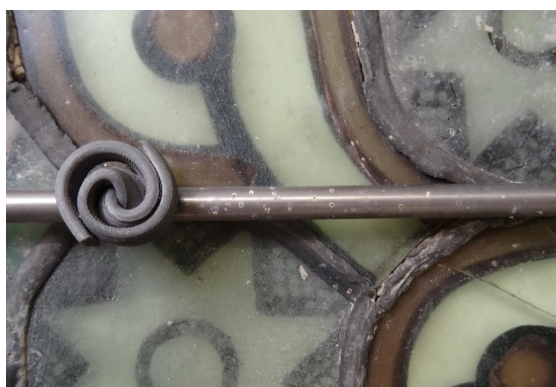
Abb. 141: Insektenkot am Windeisen
