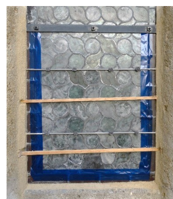
Abb. 184: Bleifeld 1b nach dem Auftrag des Mörtels.
