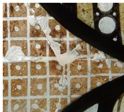
Abb. 169: Kunsthartzergänzung nach der Aushärtung im Bleifeld 1c
