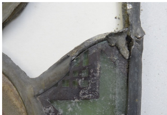
Abb. 137: Abgeschnittener Bleiflansch
