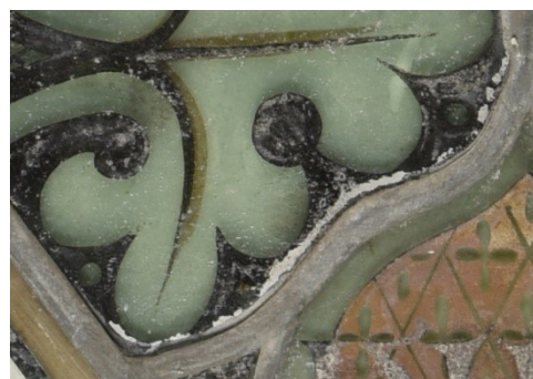
Abb. 134: Gipskruste am Glas entlang der Bleirute, Bleifeld 1d
