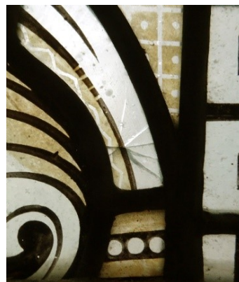
Abb. 160: Gebrochenes Glas vor der Klebung
