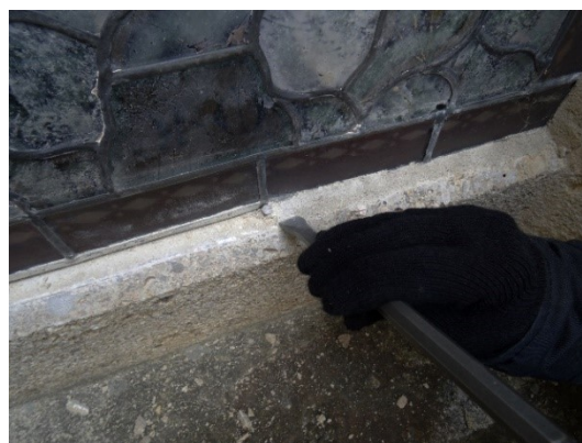
Abb. 150: Abschlagen des Mörtels
