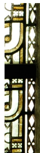
Abb. 105: Gläser vermutlich 1963 (untere Bildhälfte) und originale Gläser um 1900 (obere Hälfte)
