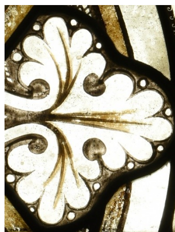
Abb. 69: Braune Emailfarbe an der Außenseite, Detail aus Bleifeld 1d, Durchlicht
