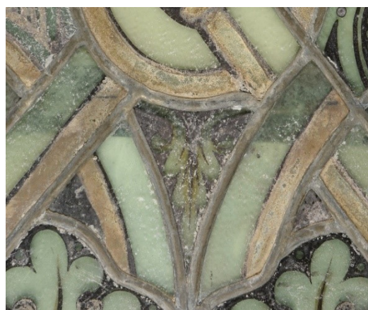
Abb. 93: Verzinnte Bleiruten, Detail aus dem Bleifeld 1d
