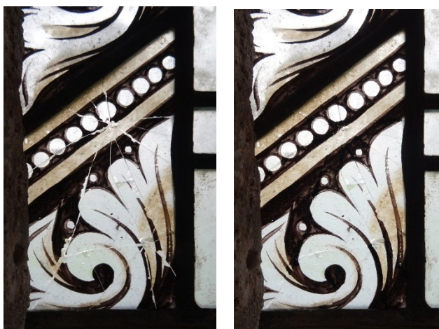
Abb. 171: Gebrochenes Glas nach der Klebung (links) und nach der Retusche (rechts)
