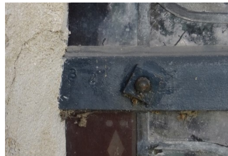
Abb. 112: Silikonabdichtung zwischen Deckschiene und Bleifeld
