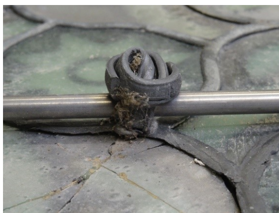
Abb. 142: Spinnweben mit organischen Ablagerungen an einer Bleischnecke
