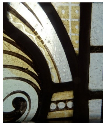
Abb. 161: Gebrochenes Glas nach der Klebung
