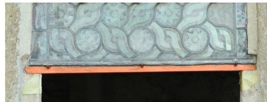
Abb. 180: Sturmeisen nach der Bleiminiumgrundierung, Außenseite
