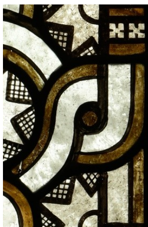
Abb. 68: Braune Emailfarbe an der Innenseite, Detail aus Bleifeld 1b, Durchlicht
