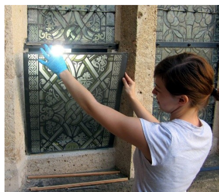
Abb. 182: Ausbau der Floatglasscheiben mit bedruckter Klebefolie
