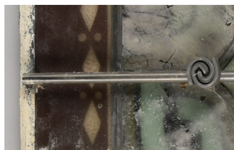
Abb. 114: Abgeschnittenes Windeisen, Bleifeld 1b
