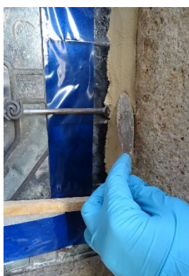
Abb. 183: Auftrag des Mörtels
