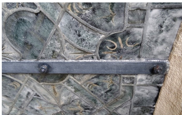
Abb. 187: Bleiwolle zwischen Deckschiene und Bleifeld
