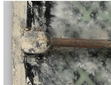
Abb. 109: Ende des Windeisens, flache Lasche, Bleifeld 1d
