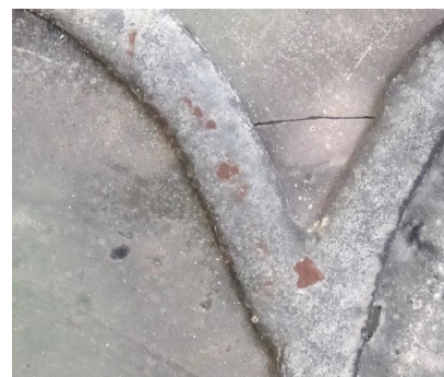
Abb. 139: Rote Rostrückstände an der Bleirute
