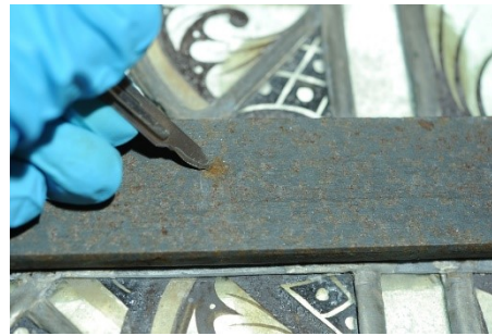
Abb. 179: Abnahme des Anstrichs und Rostreduzierung mit Skalpell
