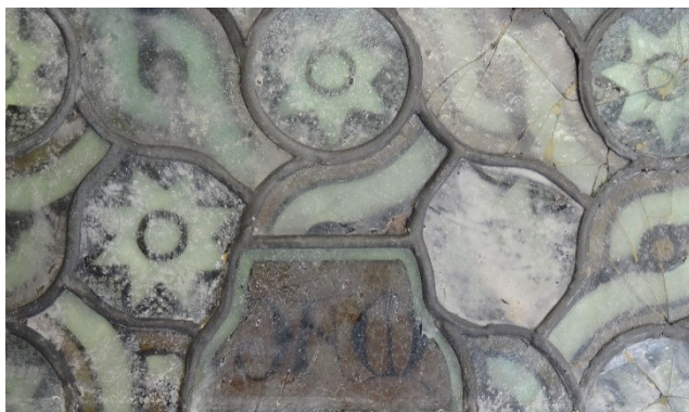
Abb. 135: Bleiruten mit verzinnter Oberfläche
