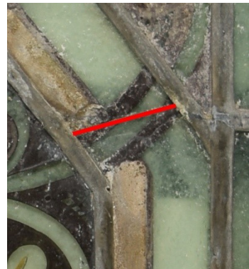
Abb. 120: Gerader Einzelsprung im Glas
