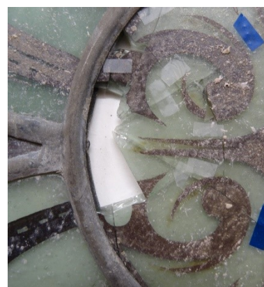
Abb. 162: Fehlstelle im Bleifeld 1b
