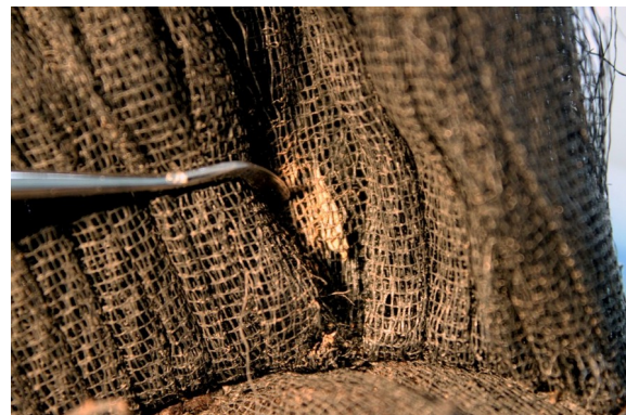
Abb. 222: Bräunlich-beige Verkrustung, rechte Seite vorne, erste Aufputzlage, Haube A
