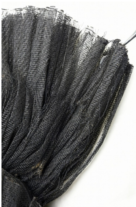
Abb. 239: Querrisse, Aufputz rechts, Haube A
