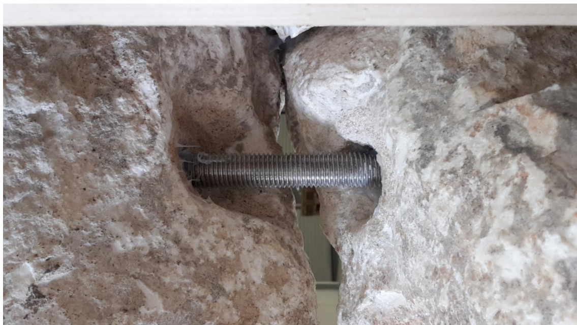
Abb. 104: Mit Epoxidharz verklebte Gewindestange.
