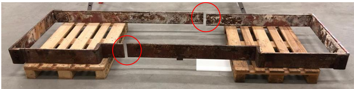
Abb. 90: Vollständig abgenommener Eisenrahmen. Rot markiert die Durchtrennung.
