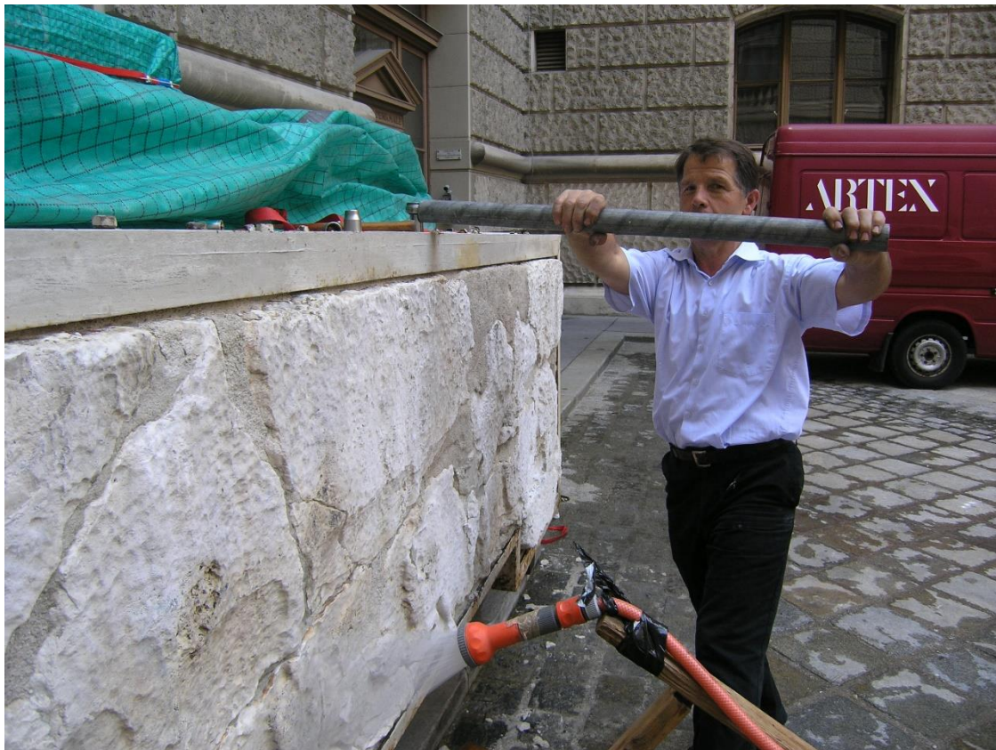
Abb. 28: Nassreinigung mit dem Wasserschlauch
