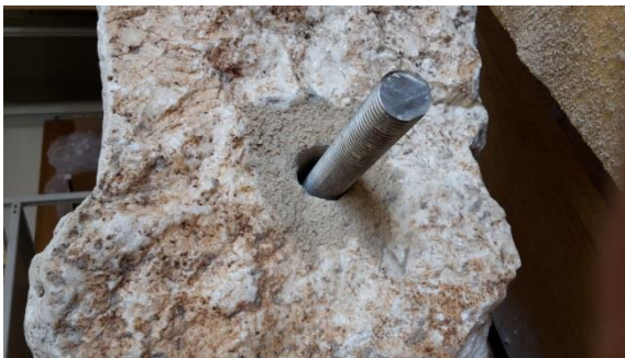
Abb. 103: Loch mit passender Gewindestange aus Niro-Stahl.
