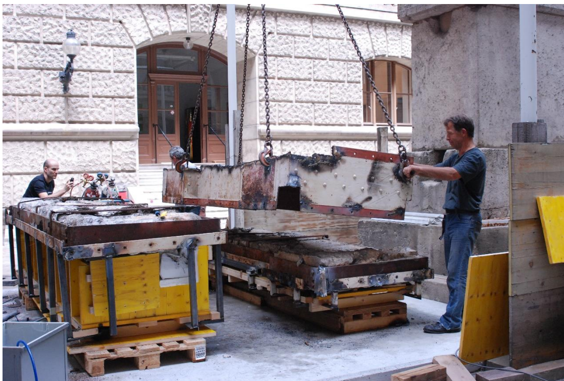
Abb. 25: Abheben des Stahlmantels mittels Kran.
