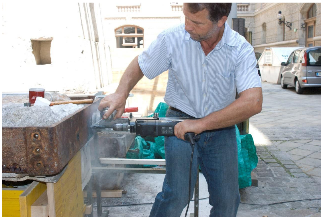
Abb. 26: Ausbohren der Gewindestangen mithilfe eines Khlsprays
