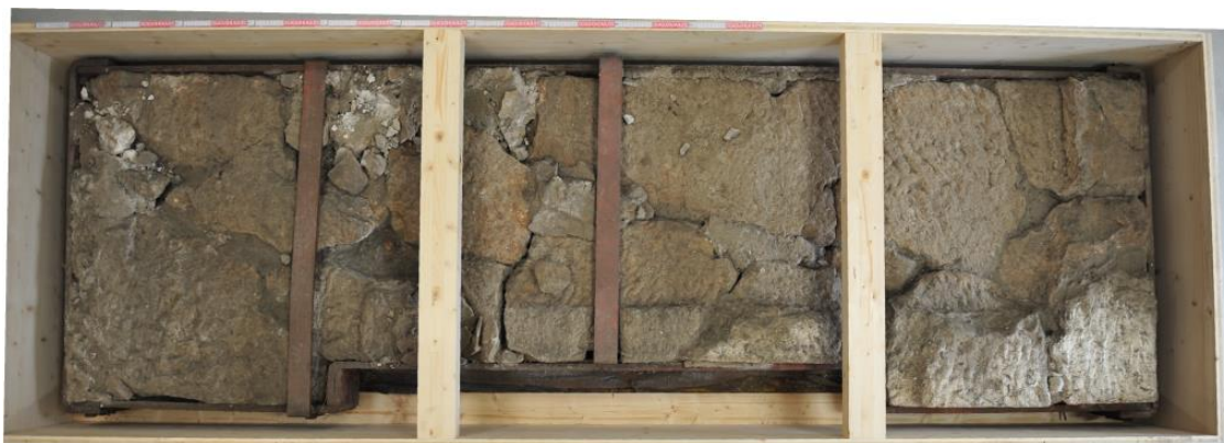
Abb. 52: Zustand zum Zeitpunkt der Übernahme des Objektes.
