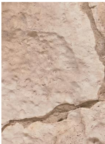
Abb. 53: Mikrokarst am Stein des Torsturzes.
