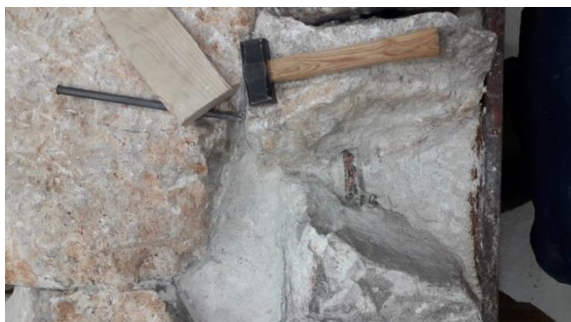
Abb. 91: Messingzapfen während der Freilegung.
