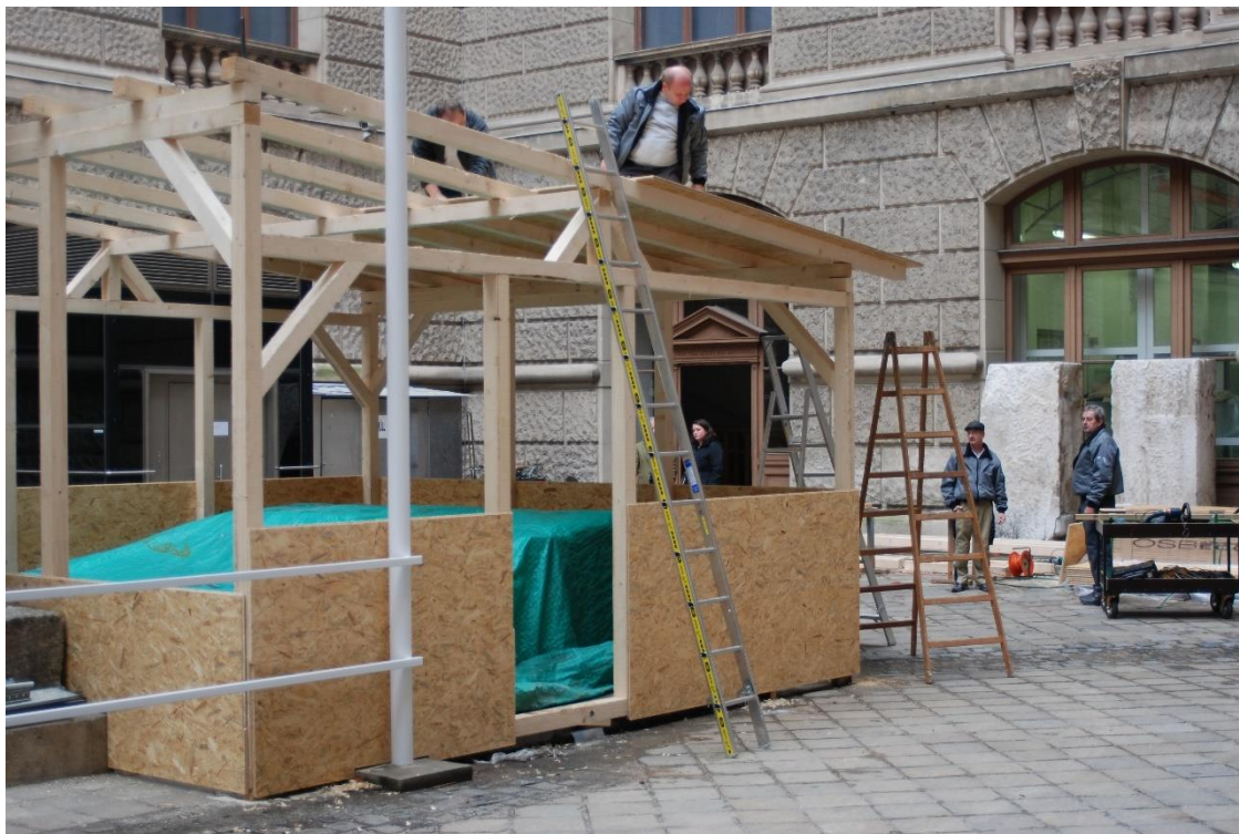
Abb. 29: Errichtung der Holzeinhausung für die Teile des Torsturzes
