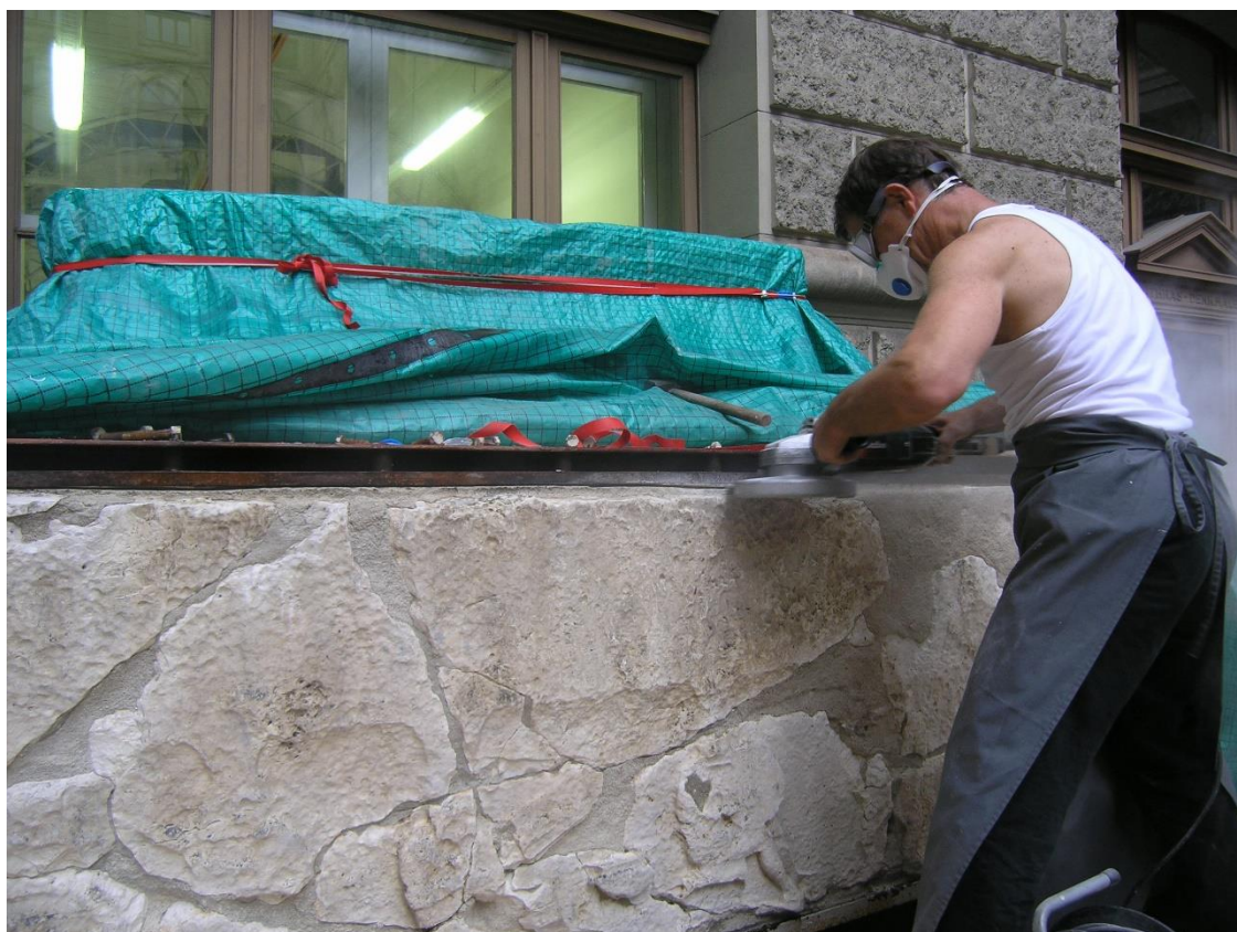
Abb. 27: Bearbeitung mit dem Winkelschleifer
