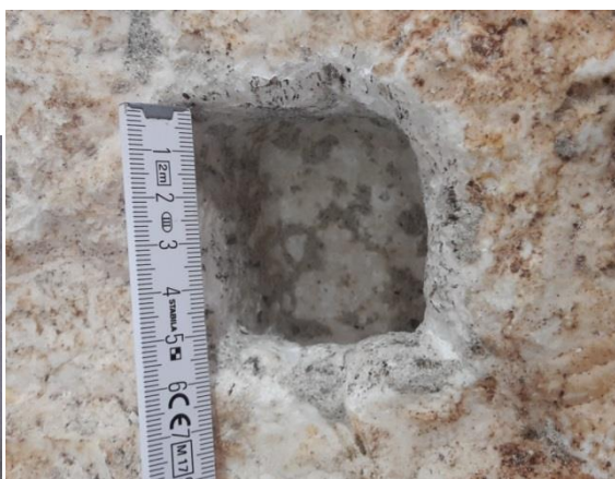
Abb. 94: Vollständig freigelegtes Loch.
