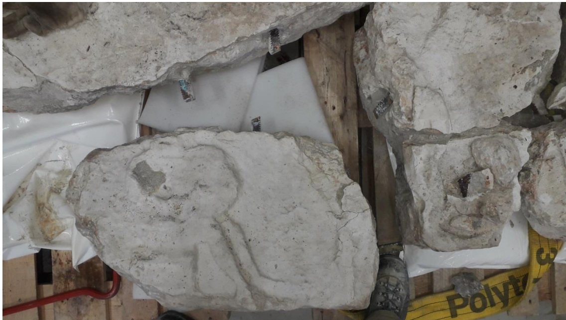
Abb. 95: Durchtrennte Messingzapfen.
