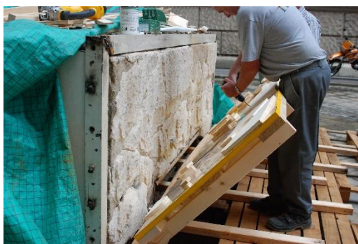
Abb.21: Anbringen der Holzkonstruktion
