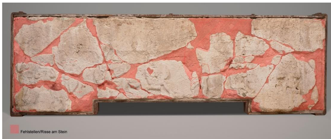
Abb. 57: Kartierung der Risse und Fehlstellen (Rot).
