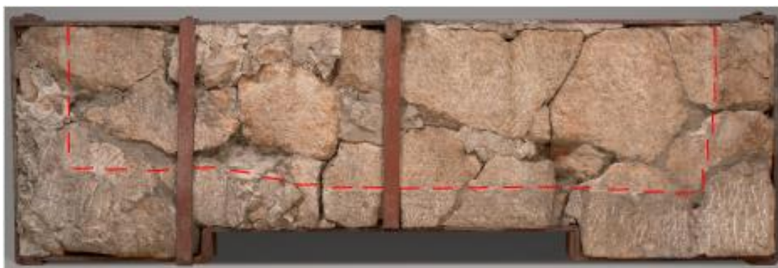
Abb. 63: Rückseite des Objektes, Unterschiedliche Verfärbungen der Oberfläche.
