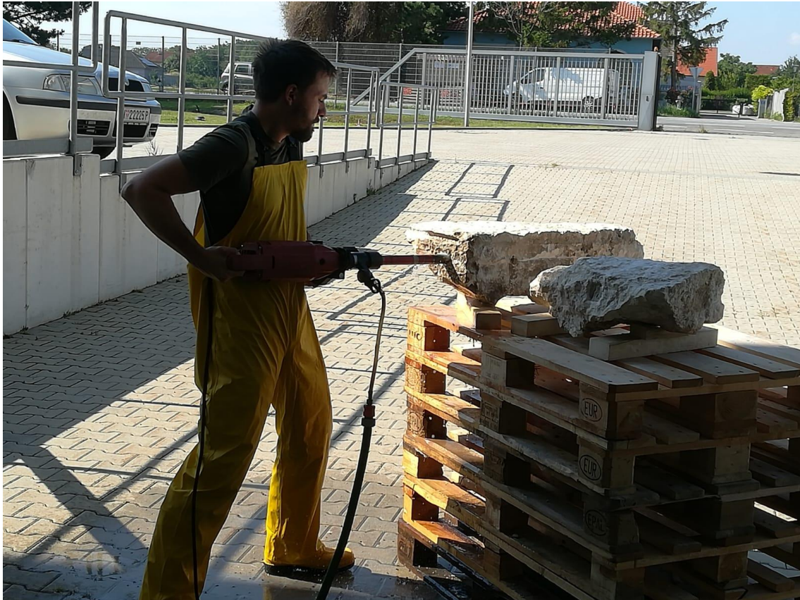
Abb. 97: Ausbohren der korrodierten Eisenzapfen mit dem Kernbohrgerät.
