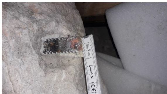
Abb. 93: Messingzapfen, mit Sorelzement vergossen.
