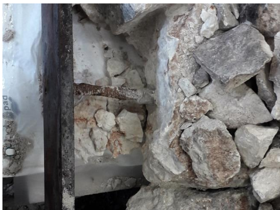
Abb. 87: Freigelegte Gewindestange.
