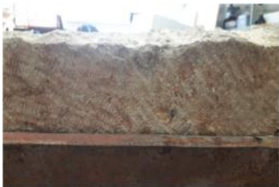
Abb. 34: Entstehungszeitliche Bearbeitung mit dem Zahneisen.
