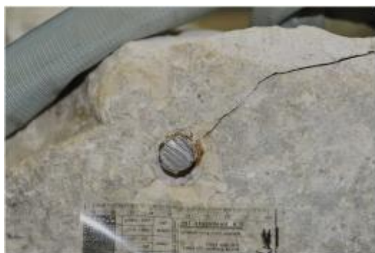
Abb. 60: Sternriss mit rostendem Eisen.
