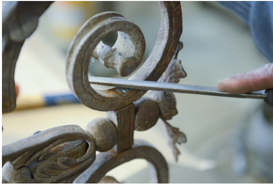
Abb. 159, Verfeilen des Nietkopfs nach dem Verklopfen.
