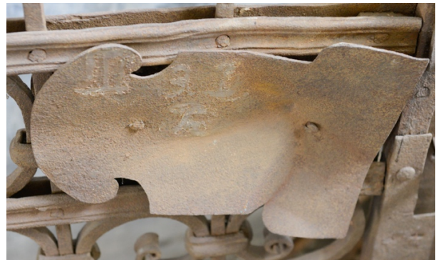
Abb. 109, Gehflügel, stark deformiertes Abdeckblech des Schlosskastens.
