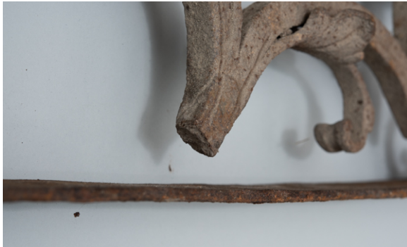
Abb. 128, Detail, Füllelement 1, Bruchstelle der abgebrochenen Volute.
