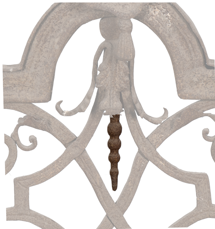
Abb. 59, zweiseitig gesenkter Perlstab nach der oben beschriebenen Technik. Füllelement der schmiedeeisernen Einfriedung.
