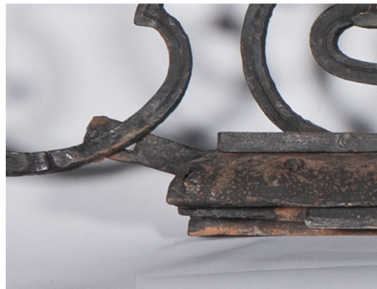
Abb. 133, Toraufsatz, links außen, verbogener Steckbolzen.
