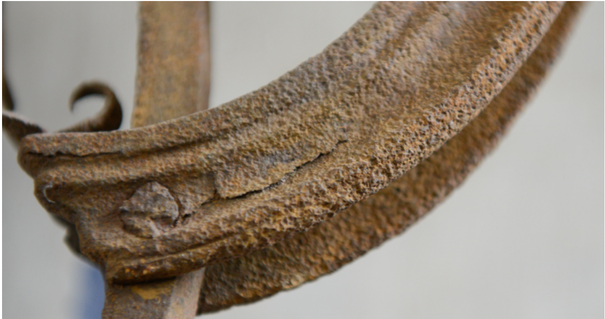
Abb. 100, weit fortgeschrittene Muldenkorrosion am Objekt, Profilleiste des Tores, starker Substanzverlust.
