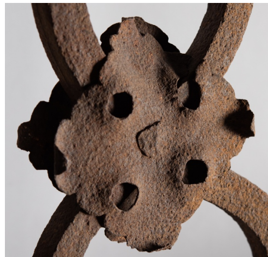
Abb. 52, getriebene Zierrosette des vorliegenden Objekts.
