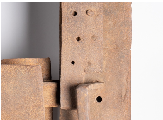
Abb. 116, Stehflügel, oberer Bereich, ein Knospenteil fehlt zur Gänze (links).
