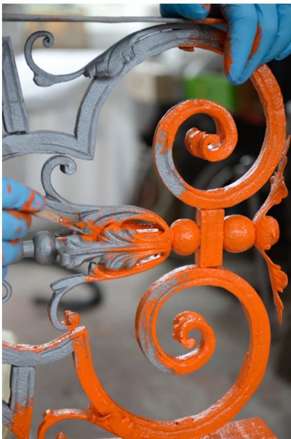
Abb. 171, Einbringen der Grundierung in Vertiefungen mittels Fladerpinsel.
