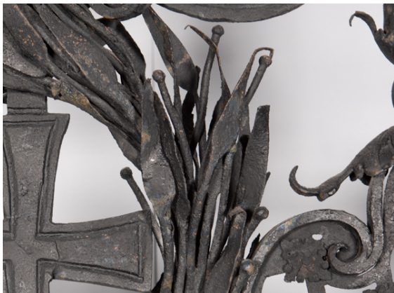
Abb. 132, Toraufsatz, Ehrenkranz, Detail, etliche verbogene Blätter.
