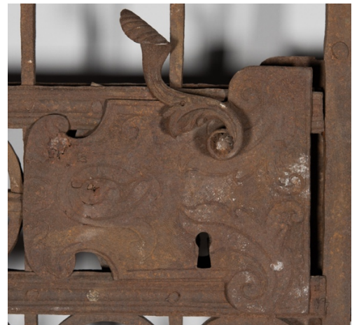
Abb. 63, Zierkehlungen auf dem Schlosskasten des Gehflügels.
