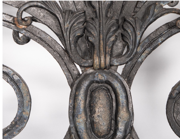
Abb. 141, Detail von Abb. 21, diffundierende Eisenkorrosion, Abplatzen des Schichtpaketes.
