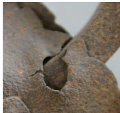
Abb. 111, Gehflügel, oben links, Riss im Blech einer Zierrosette.
