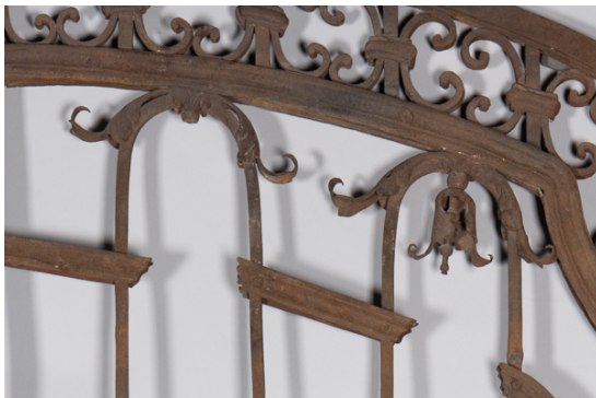
Abb. 116, Stehflügel, oberer Bereich, ein Knospenteil fehlt zur Gänze (links).
