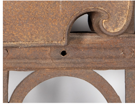
Abb. 113, Stehflügel, Rahmen unter dem Schlosskasten, fehlender Niet.
