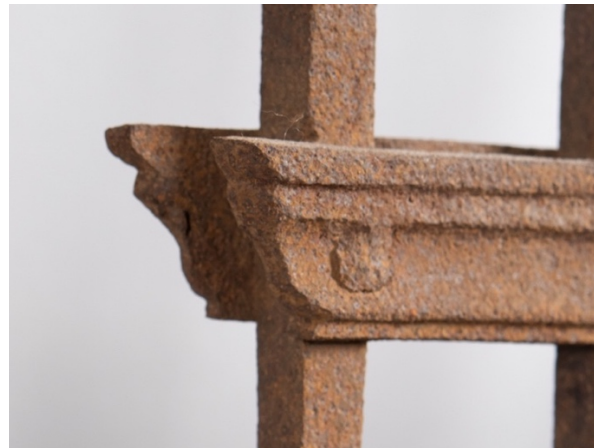
Abb. 55, gesenkschmiedetes Element der schmiedeeisernen Einfriedung. Stehflügel.
