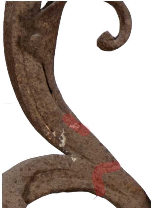
Abb. 65, der rote Bereich markiert die Feuerschweißungen, Füllelement.
