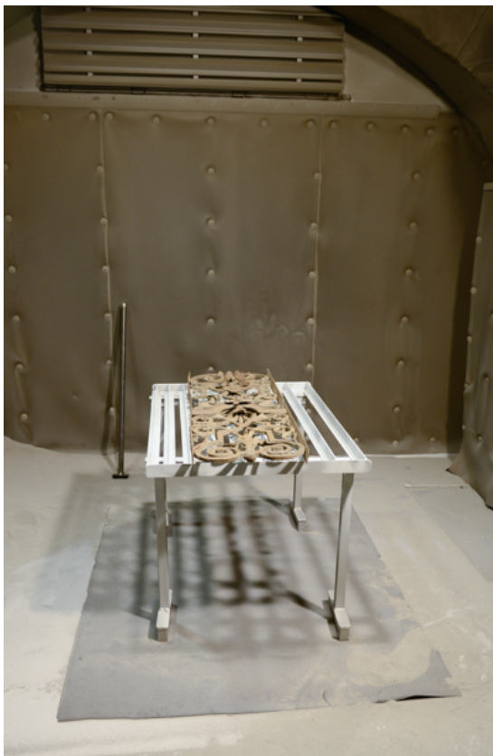
Abb. 165, Füllelement in der Strahlkammer.
