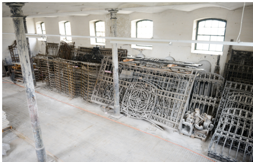
Abb. 106, großer Lagerraum, diverse Gitterelemente. Ansicht 2.
