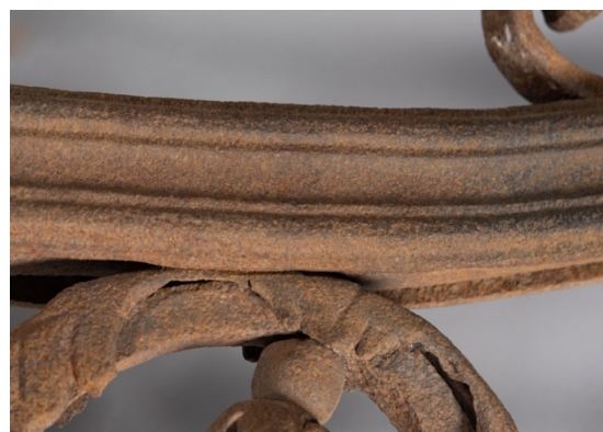
Abb. 55, gesenkschmiedetes Element der schmiedeeisernen Einfriedung. Stehflügel.
