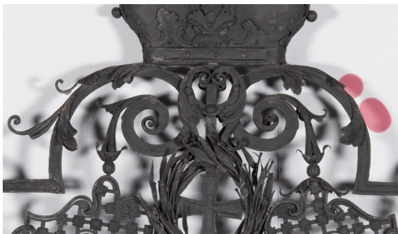
Abb. 134, Toraufsatz, zentraler Bereich, fehlende Blattranken auf der rechten Seite (rote Markierung).
