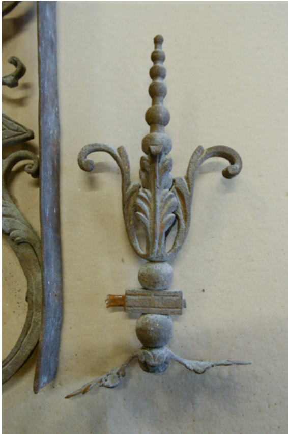
Abb. 153, Perlstab nach dem Entfernen.
