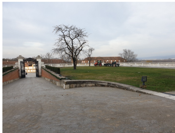
Abb. 9, die nordöstliche Auffahrtsrampe.
