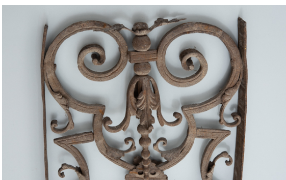
Abb. 124, Füllelement 1, oberer Bereich, gerissener Niet und dadurch lockerer Perlstab.
