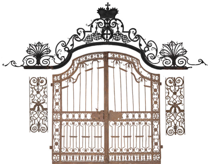
Abb. 33, Tor, links: Gehflügel, rechts: Stehflügel; links und rechts außen: Füllelemente, oben: Toraufsatz.
