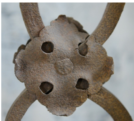
Abb. 110, Gehflügel, oben links, Deformierung einer Zierrosette.
