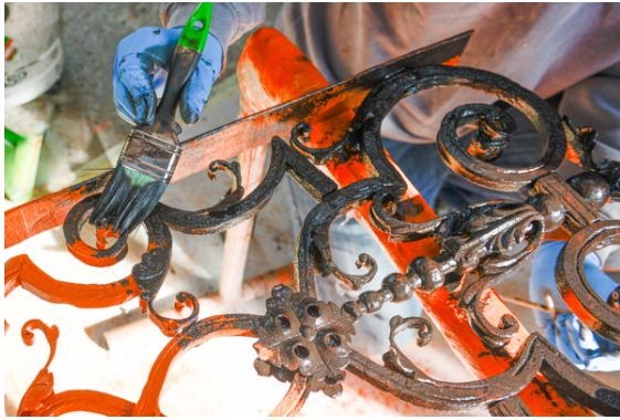
Abb. 177, Aufbringen des ersten Deckanstrichs.
