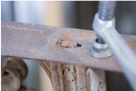
Abb. 161, ausgerissener Nietkopf.
