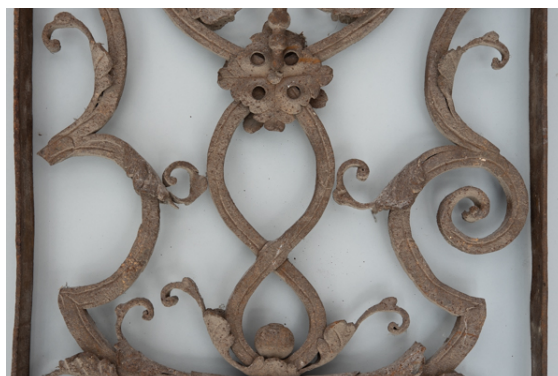
Abb. 127, Füllelement 1, abgebrochene Volute links.
