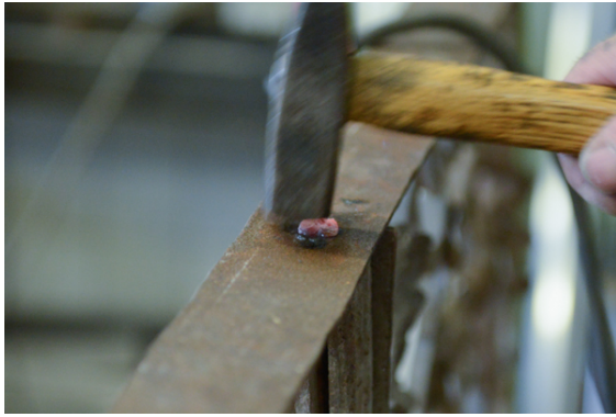
Abb. 163, Verklöpfen des noch glühenden Niets.
