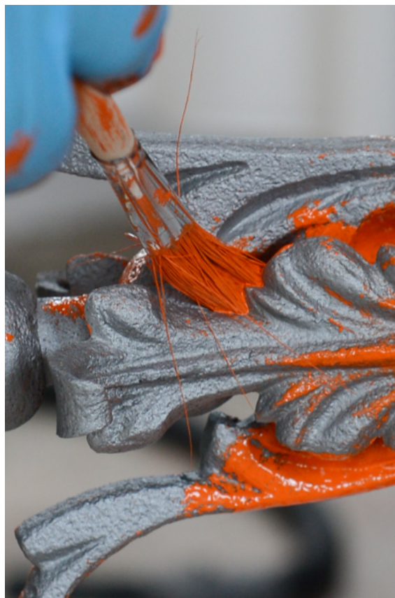
Abb. 172, Einbringen der Grundierung in Vertiefungen mittels Fladerpinsel, Detail.
