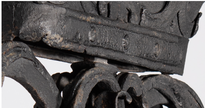
Abb. 71, Nieten im Bereich der Krone, Toraufsatz.
