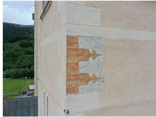
Abb.119: Nordturm, Freilegefenster Diamanteck-Quaderung, 2020
