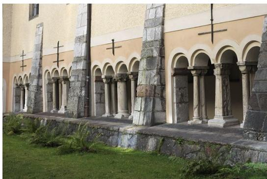
Abb. 65: verstärkte Kreuzgangmauer, Berchtesgaden
