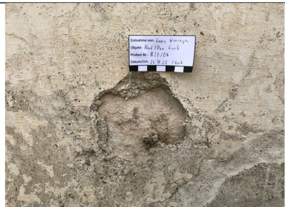
Detailaufnahme mit Probeentnahmestelle
