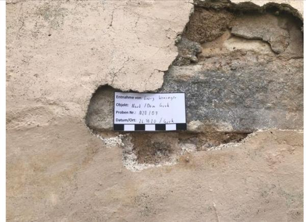
Detailaufnahme mit Probeentnahmestelle
