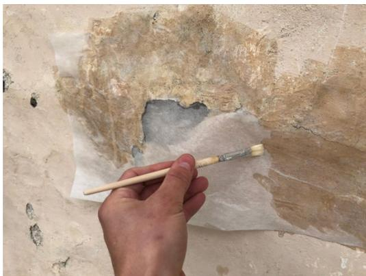
Abb.193: Auftrag des Klebemittels
