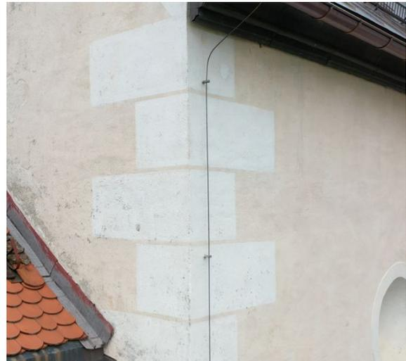
Abb.84: nördliche Querschiffkante, Eck-Quaderung,
