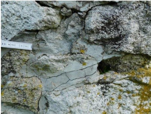
Abb. 74: Raum 10, äußere Nordmauer, Detailfoto Rissige Zementfuge.
