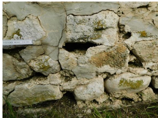
Abb. 87: Raum 3, äußere Nordmauer, Pflanzenwachstum in Fugenfehlstelle.
