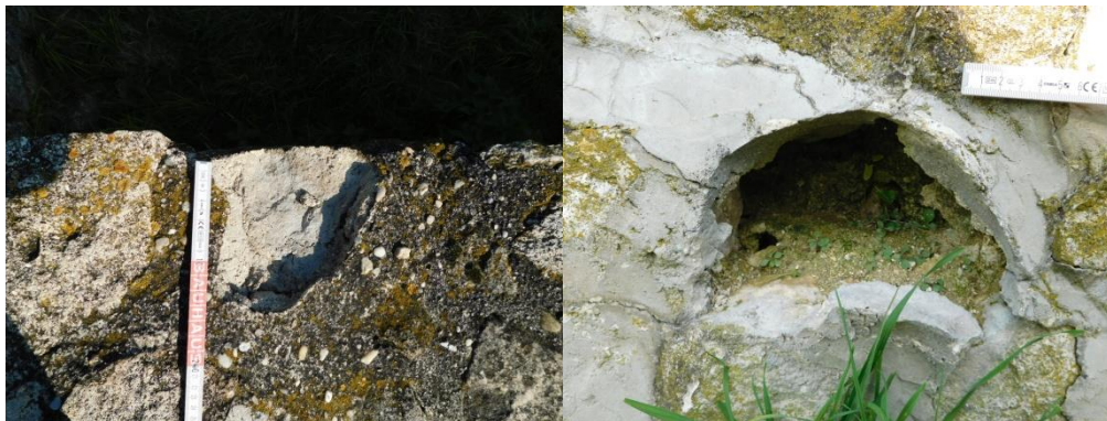
Abb. 65: Verlorene Bruchsteine im Mauerwerk, links: Raum 6, rechts: Raum 13.
