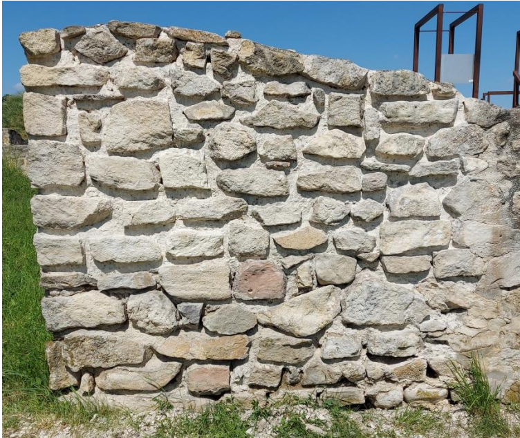
Abb. 128: Musterfläche an äußerer Westmauer von Raum 10 nach Entfernung der rezenten Fugen.
