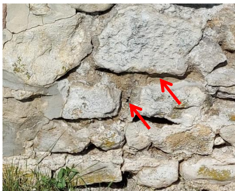
Abb. 115: Raum 10, äußere Westmauer, Dauerfeuchter römischer Mörtel (rote Pfeile).
