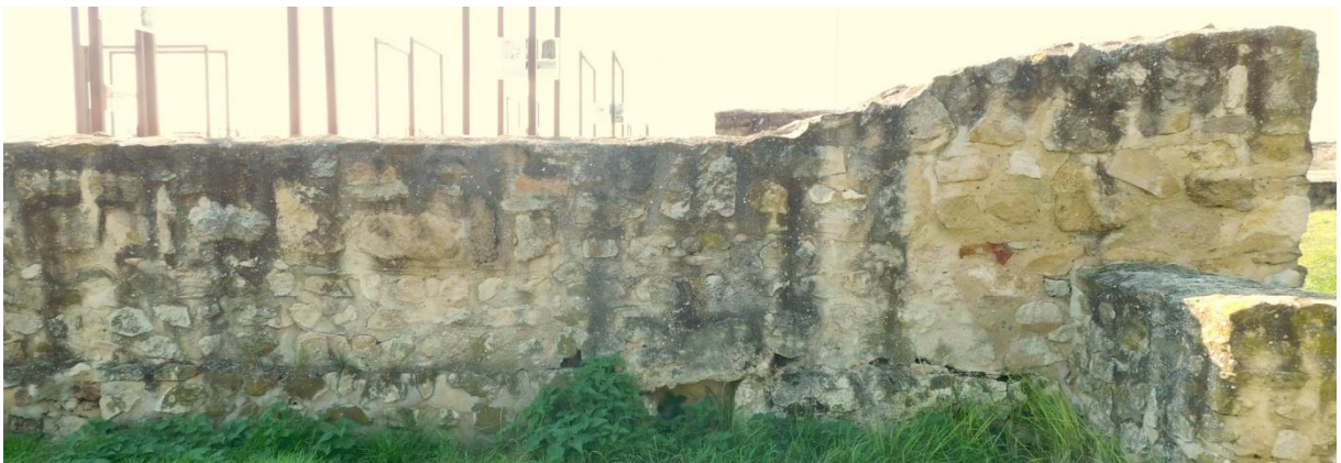
Abb. 72: Raum 6, äußere Ostmauer; biogene Besiedelung.
