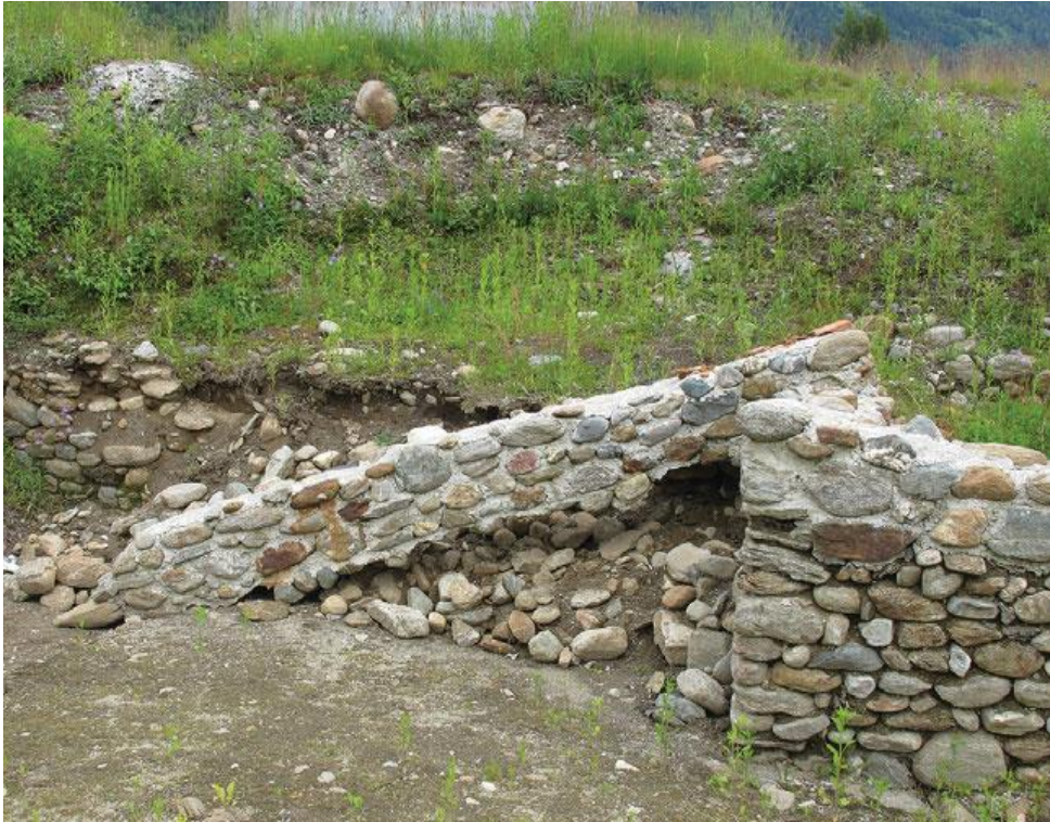
Abb. 138: Unter dem Gewicht der zu dichten rekonstruierten Mauerkappe (mit Trasszementmörtel) kollabiertes Originalmauerwerk, Archäologischer Park Aguntum bei Lienz (Tirol).
