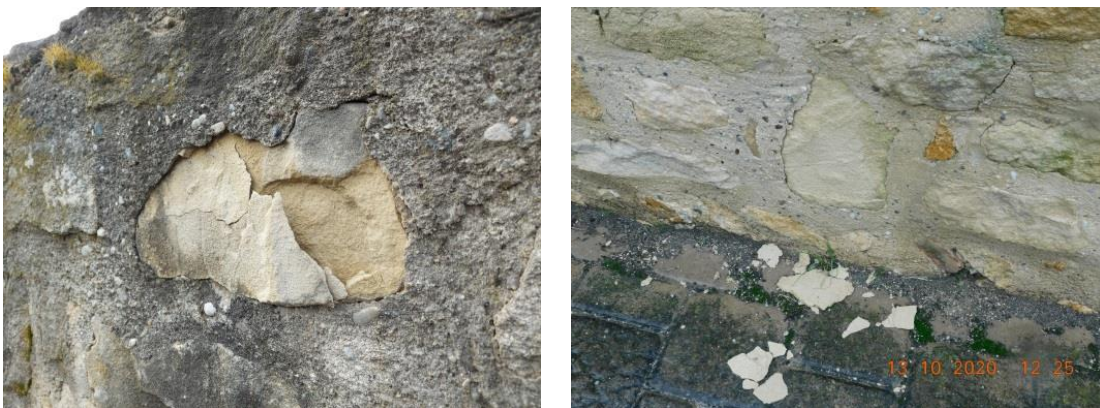
Abb. 63: Raum 19 (links) und 18 (rechts), Detailfotos Schalenbildung bzw. Frost-Tau-Schäden an Kalkarenit.
