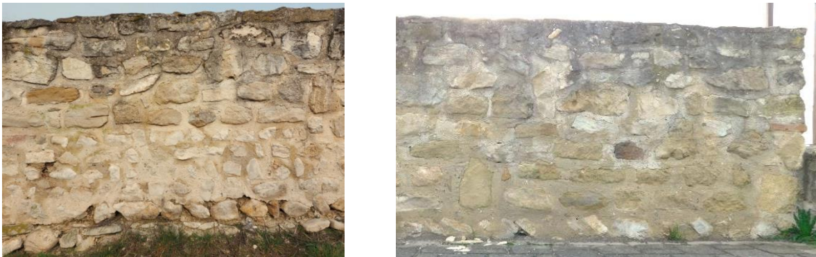
Abb. 93: Raum 21, Abschnitt der äußeren Südmauer mit Feuchtezon.
