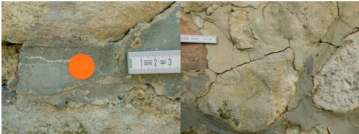
Abb. 53: Detailfoto Zementmörtel, rechts: die sichtbare unterschiedliche Färbung (grau, beige) resultierte durch Kalkausblühungen während des Abbindens.
