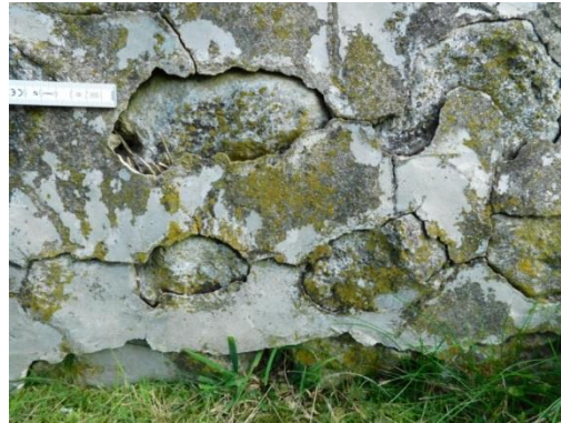
Abb. 74: Raum 10, äußere Nordmauer, Detailfoto Rissige Zementfuge.
