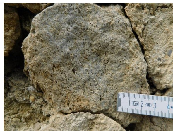
Abb. 40: Raum 21, Nordmauer, römischer Bruchstein, poröser Algenschuttkalk.
