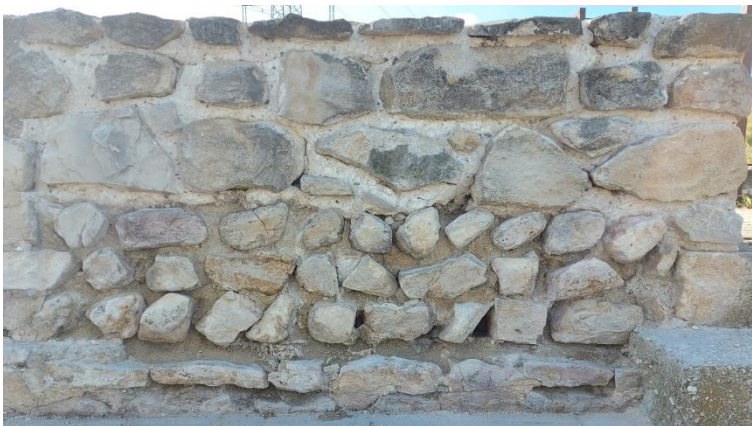
Abb. 129: Musterfläche an Mauerabschnitt der Nordmauer von Raum 21 nach Entfernung der rezenten Fugen.
