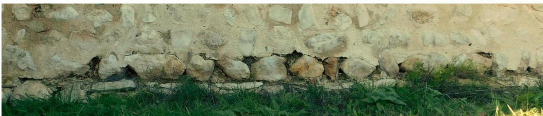
Abb. 86: Raum 21, äußere Südmauer, Offene Bodenfuge.
