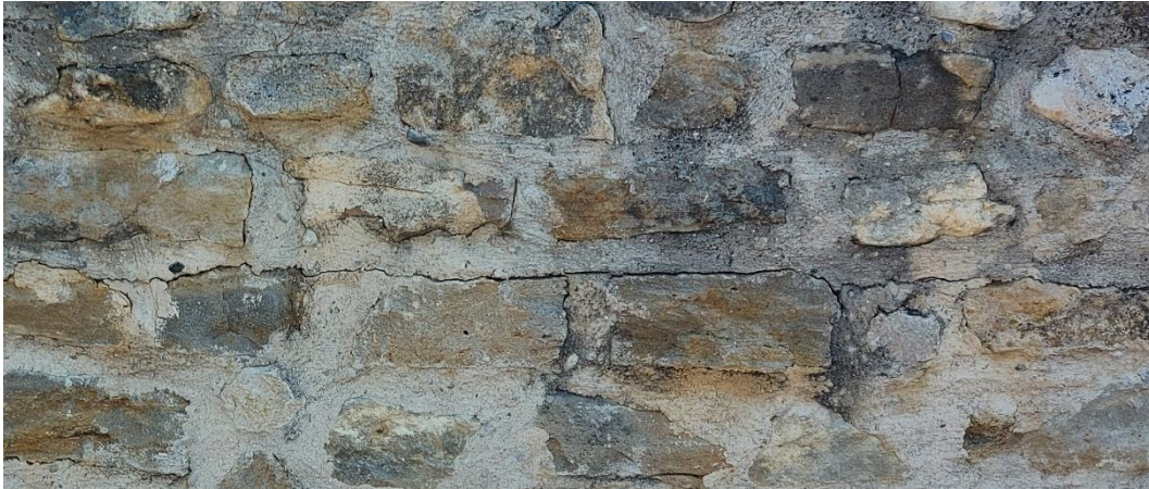
Abb. 78: Raum 9, Ostmauer, Detailfoto Flankenrisse an Trasszementfugen.
