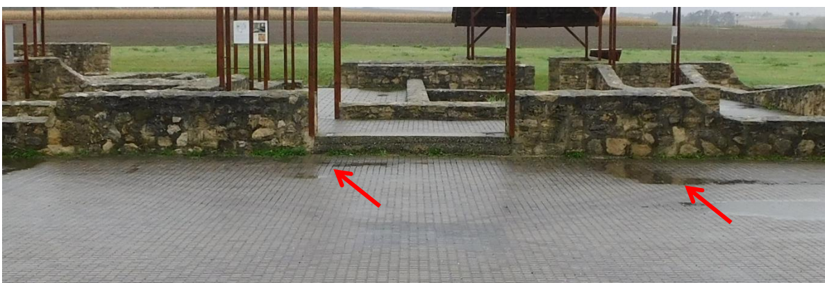
Abb. 94: Raum 18, Westmauer mit Feuchtezon.
