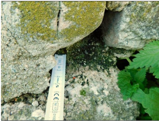
Abb. 84: Raum 6, äußere Ostmauer, offene Bodenfuge.
