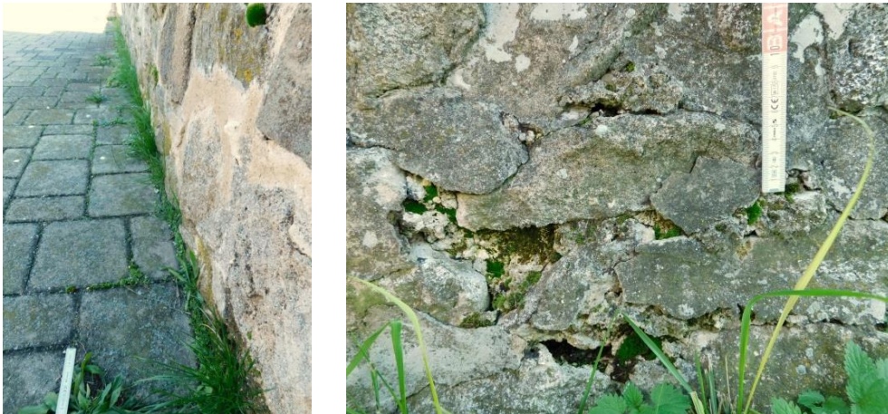
Abb. 91: Raum 21, innere Südmauer, Pflanzenbewuchs entlang des Mauerfußes.
