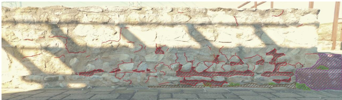
Zustandskartierung - Abschnitt der Nordmauer Raum 21, Römische Palastanlage Bruckneudorf
