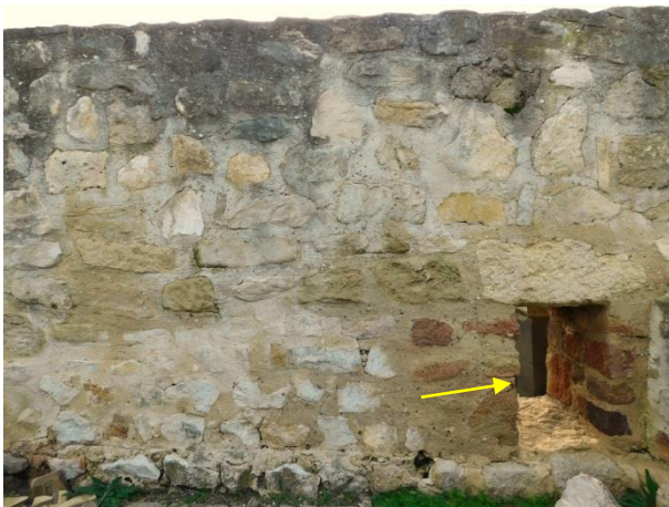
Abb. 12: Westmauer Raum 19; hervorgehoben ist die Feuerstelle ( praefurnium ) und die Durchzugsöffnung, über die der Hohlraum unter Raum 27 beheizt wurde.
