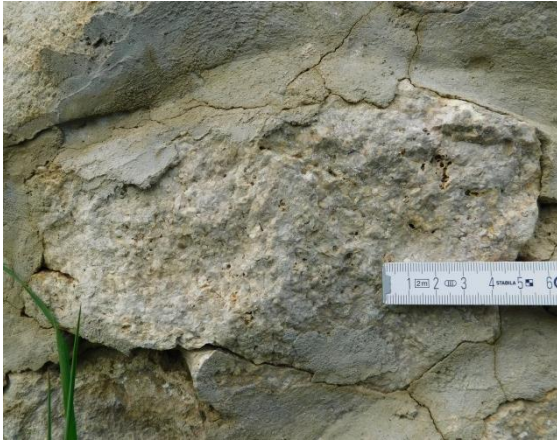
Abb. 39: Raum 20, äußere Südmauer, römischer Bruchstein, dichter Algenschuttkalk.
