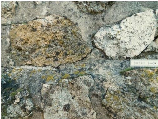
Abb. 76: Raum 3, äußere Nordmauer, Detailfoto Flankenrisse an Zementfuge.
