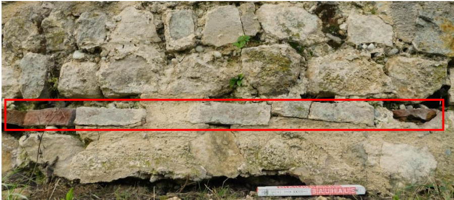
Abb. 46: Mauerwerk mit Ziegeldurchschuss (rot eingerahmt), äußere Südmauer von Raum 16.
