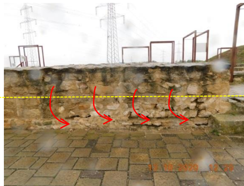
Abb. 113: Raum 13, Ostmauer, Durchfeuchtung aufgrund von Sickerwasser.
