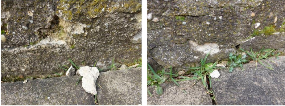
Abb. 116: Raum 13, Detailfotos Frost-Tau-Schaden an Fugenmörtel.
