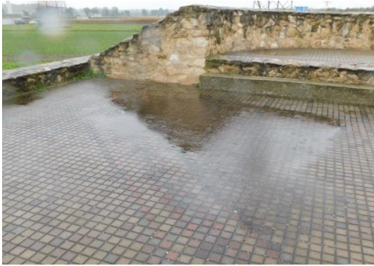
Abb. 100: Raum 1, Bereich mit abgesunkenem Bodenpflaster.
