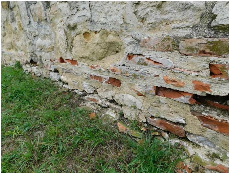
Abb. 68: Raum 1, äußere Westmauer, Schäden an Ziegellagen.
