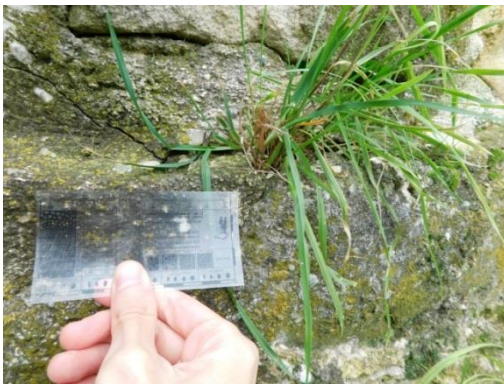
Abb. 80: Raum 1, äußere Ostmauer: Pflanzenwachstum in Fugenrissen.
