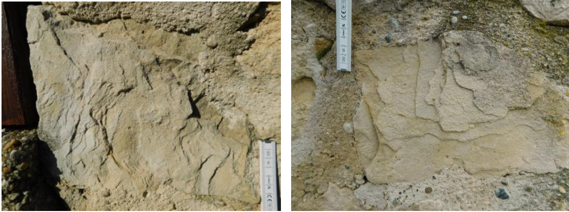
Abb. 62: Schalenbildung an dem Windener Kalkarenit, links: Raum 21; rechts: Raum 18.
