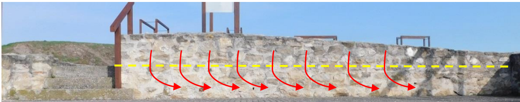
Abb. 79: Raum 9, Ostmauer, Schäden aufgrund von Sickerwasser (rote Pfeile) über Bodenpflaster von Raum 11 (gelbe strichlierte Linie).
