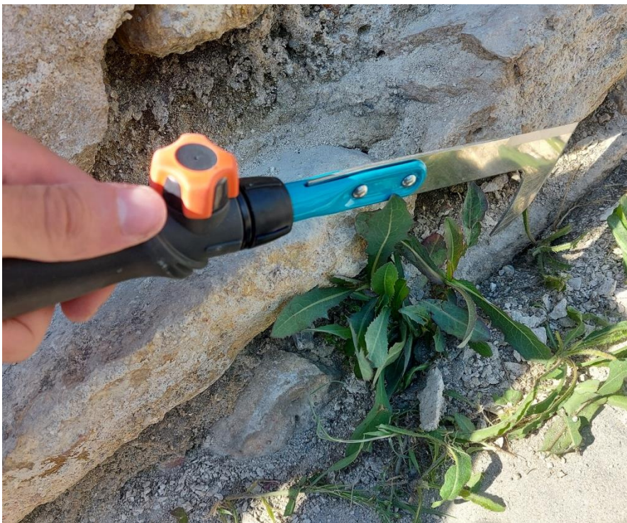
Abb. 127: Entfernung des Pflanzenbewuchses am Mauerfuß mittels Fugenkratzer.
