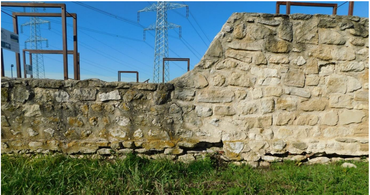
Abb. 71: Raum 21, Abschnitt der äußeren Südmauer, linkes Ende mit ausgeprägter biogener Besiedelung.
