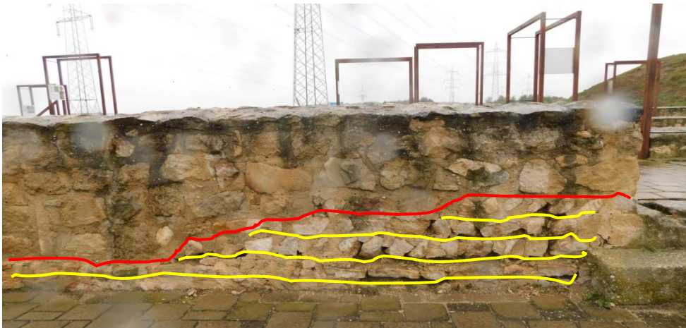
Abb. 35: Raum 21, Abschnitt der Nordmauer, gelb hervorgehoben sind die waagerechten Bruchsteinlagen des römischen Mauerwerks; rot hervorgehoben ist die Trennlinie zwischen dem römischen Mauerwerk und der Aufmauerung aus den 2000er Jahren.
