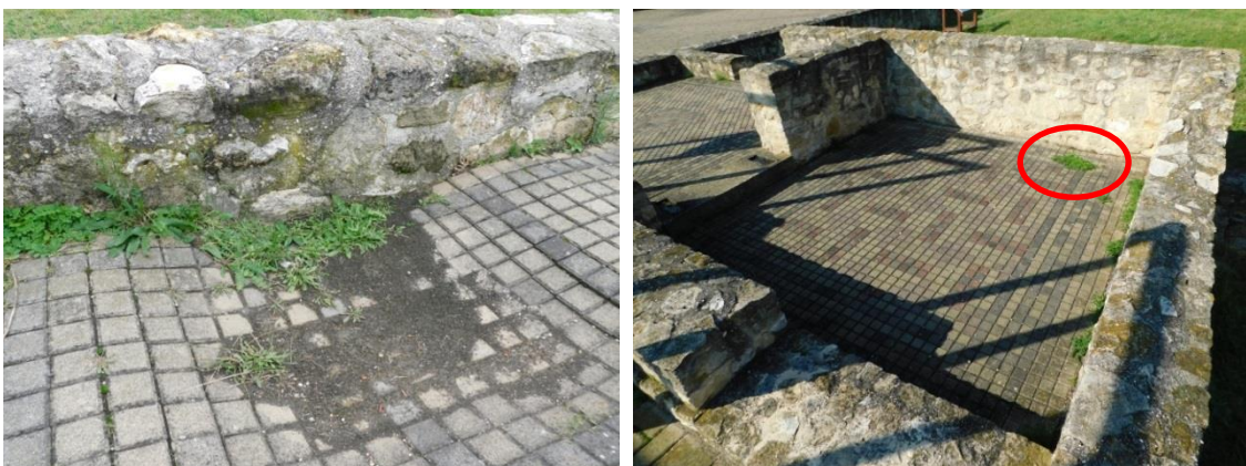
Abb. 98: Raum 1, abgesunkene Bodenpflasterung mit Pflanzenwachstum.
