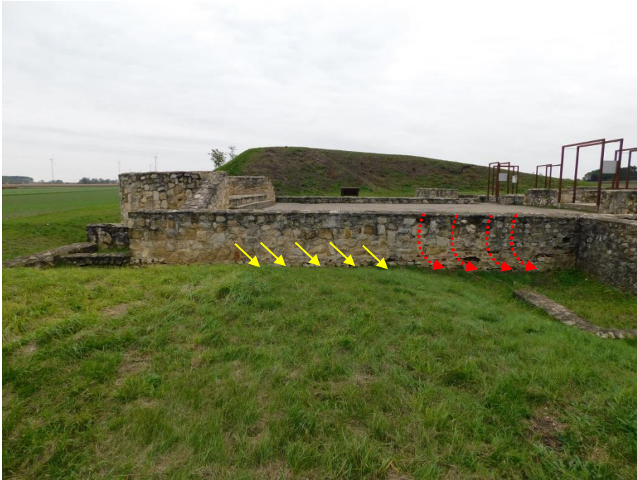
Abb. 69: Raum 1, äußere Westmauer, Dauerfeuchte durch Sickerwasser (rote Pfeile) und durch an der Böschung ab rinnendes Regenwasser (gelbe Pfeile).
