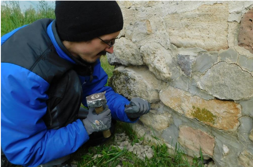
Abb. 126: Entfernung rezenter Fugen mit Hammer und Meißel.
