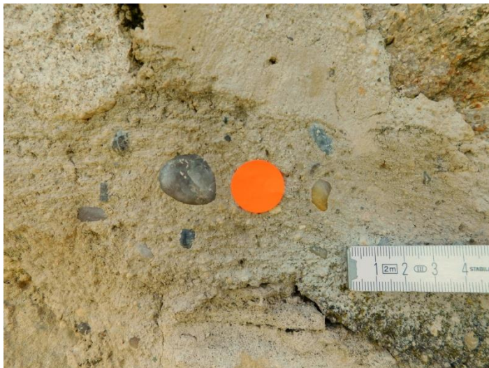
Abb. 56: Detailfoto Trasszementmörtel aus der (Teil-)Rekonstruktionsphase 2004-2006.
