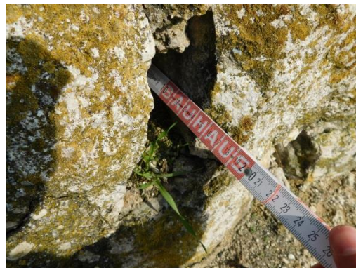
Abb. 87: Raum 3, äußere Nordmauer, Pflanzenwachstum in Fugenfehlstelle.
