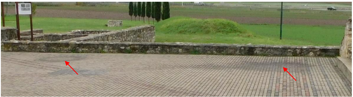
Abb. 97: Raum 1, die roten Pfeile verweisen auf jene durch biogenen Bewuchs dunkel gefärbten abgesunkenen Bereiche des Bodenpflasters.
