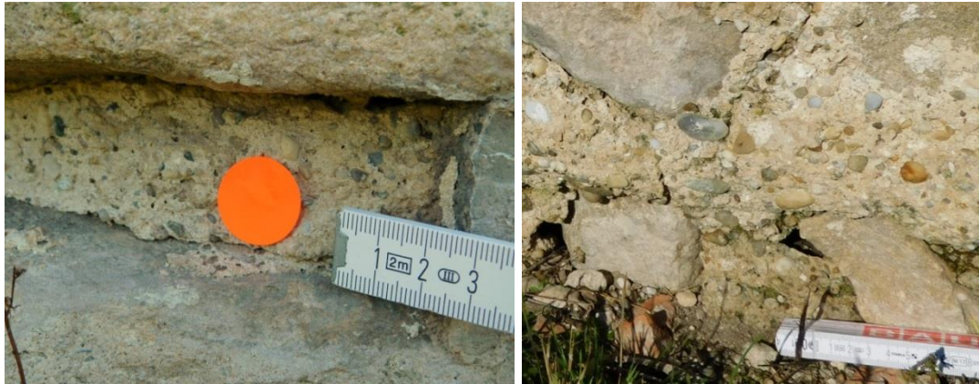
Abb. 48: Römischer Versatz- oder Fugenmörtel, äußere Westmauer von Raum 10; hier ist der römische Mörtel durch eine Fehlstelle im rezenten Mörtel (rechter Bildrand) erkennbar.
