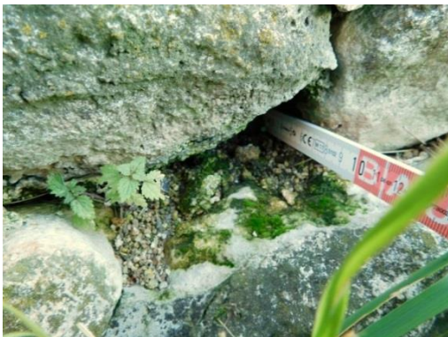
Abb. 87: Raum 3, äußere Nordmauer, Pflanzenwachstum in Fugenfehlstelle.
