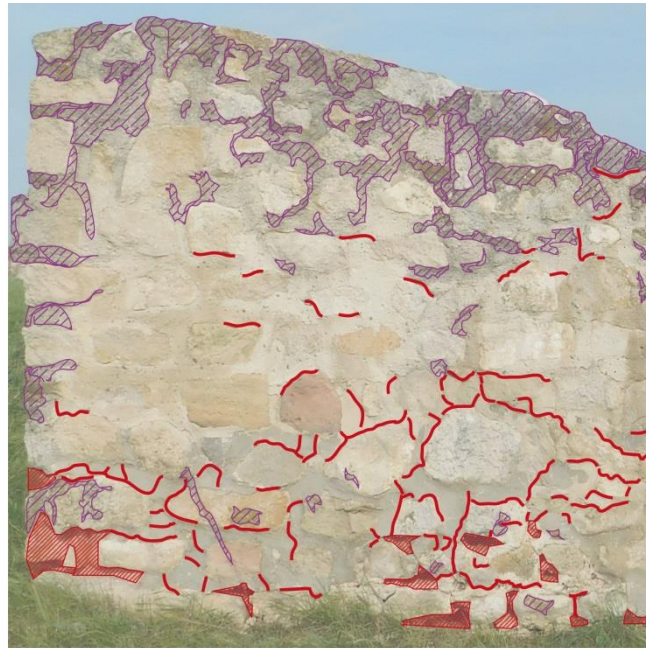
Zustandskartierung - Abschnitt der äußeren Westmauer Raum 10, Römische Palastanlage Bruckneudorf
