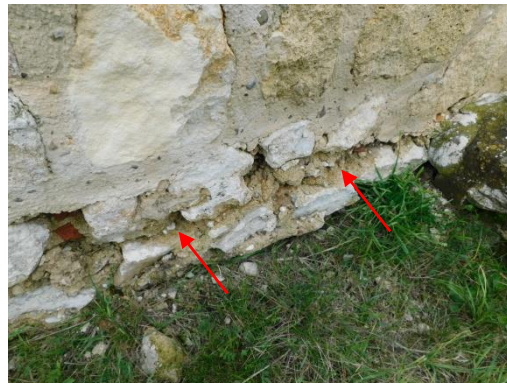
Abb. 85: Raum 1, äußere Westmauer, offene Bodenfuge mit dahinterliegendem römischem Mörtel (rote Pfeile).
