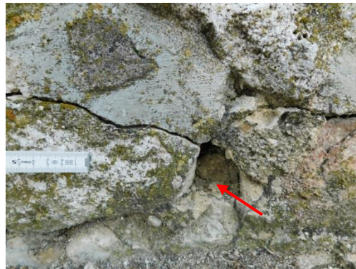
Abb. 76: Raum 3, äußere Nordmauer, Detailfoto Flankenrisse an Zementfuge.
