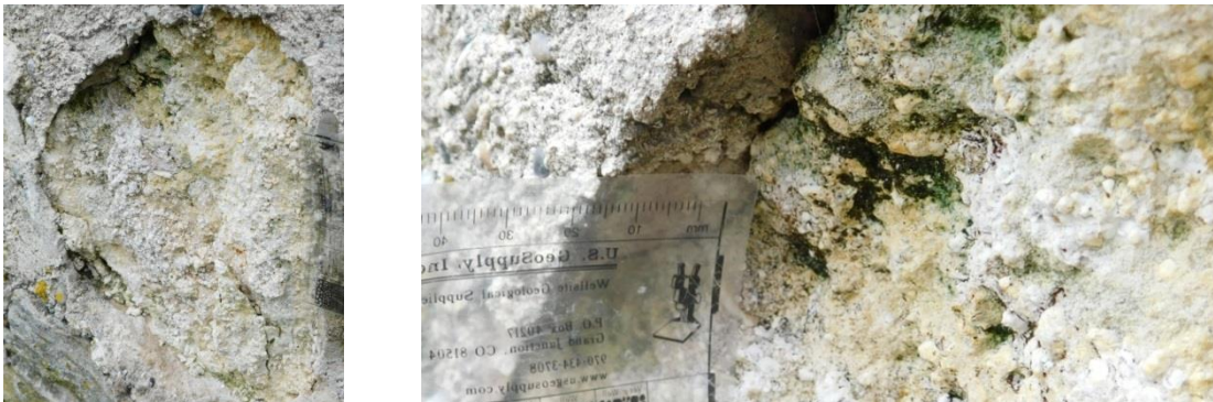
Abb. 64: Zurückgewitterter Kalkarenit, Raum 2 Äußere Nordmauer.
