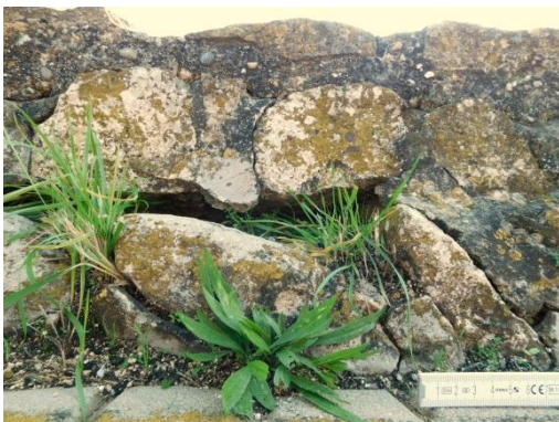
Abb. 89: Raum 4, Südmauer, Fehlstelle an Fuge.
