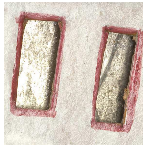
Abb. 287 (Inv.Nr. 50401) Korrosion der Spiegelstücke
