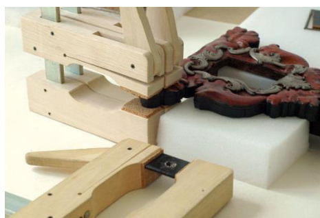
Abb. 203: Verklebung unterschiedlicher Elemente und Fixierung mit Klemmzwingen.
