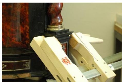
Abb. 202: Verleimung einer lose beiliegenden Profileiste am Prunkschrank.
